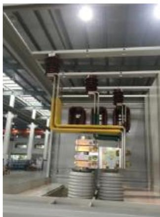
d. 手动操作隔离开关、断路器机械连锁程序等 3~5 次，应灵活无卡住现场，且应动作准确，程序无误。
