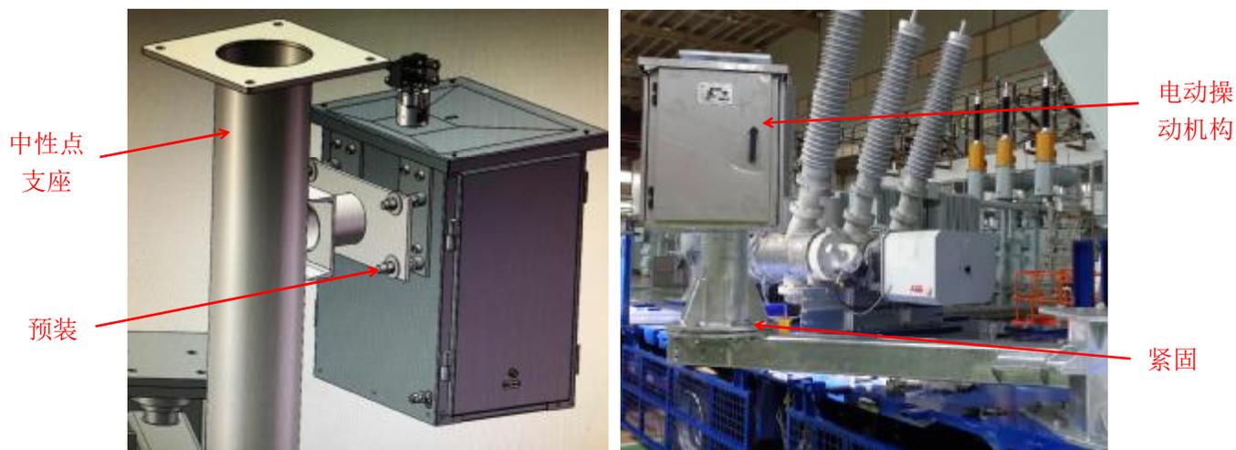
2.7.3 中性点成套装置与中性点支座安装，待螺栓紧固后，拆除卸扣、吊带。
