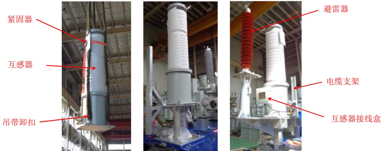
避雷器安装：①先用图纸指定紧固件将三角板和避雷器组装；②用指定螺栓从底板反穿，套入瓷套、三角板、瓷套再紧固。③用行车吊运避雷器与底座组装。
