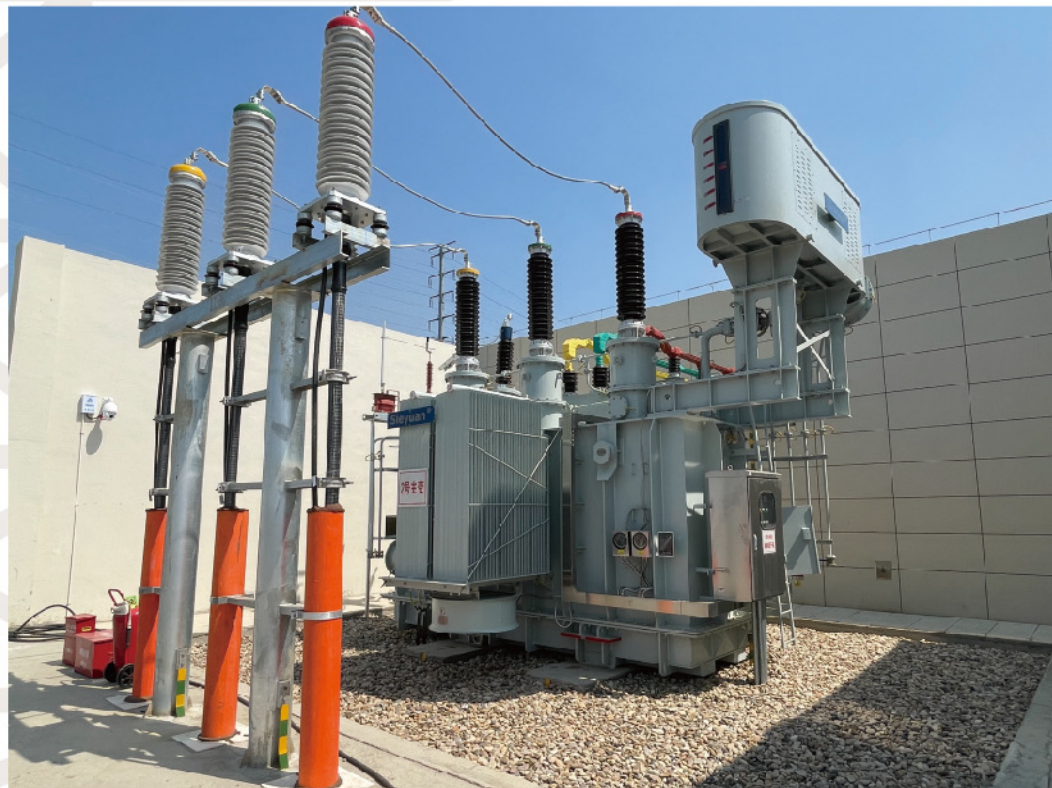
江苏省常州东方日升 110kV 变电站项目
